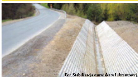
Fot. Stabilizacja osuwiska w Librantowej.
