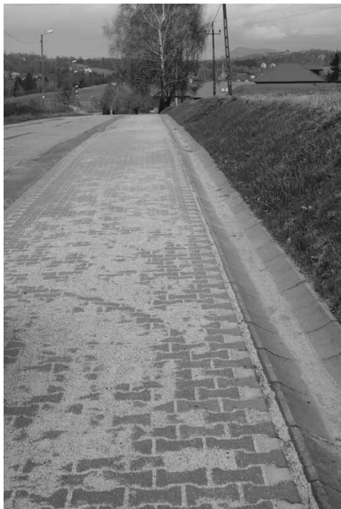
Wybudowany chodnik w Mszalnicy
