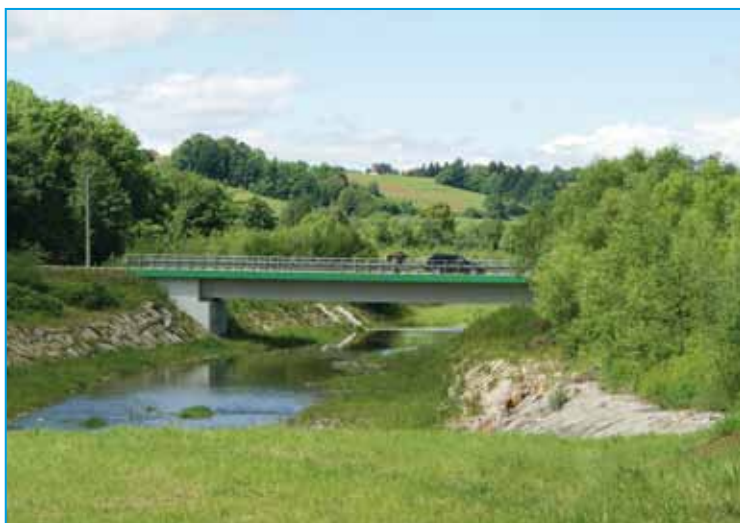
Remont mostu w Kamionce Małej 2010-2011 rok, dofinansowanie ze środków UE „Fundusz Solidarności” oraz z Ministerstwa Spraw Wewnętrznych w ramach usuwania skutków klęsk żywiołowych. Koszt inwestycji – 3.237.260 zł.
