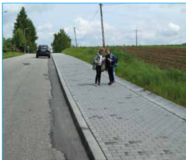
Wybudowany odcinek chodnika przy drodze powiatowej w Mszalnicy – 2013 rok, dofinansowanie z PROW 2007-2013 – LGD „Korona Sadecka” Odnowa i Rozwój Wsi. Koszt inwestycji - 105.940 zł
