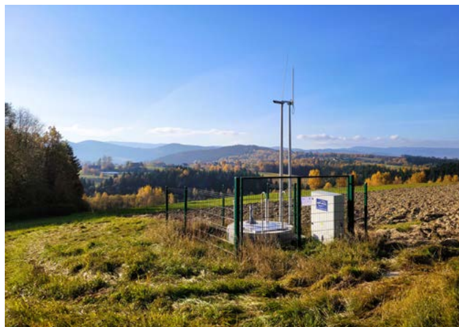
Kanalizacja w Mystkowie
