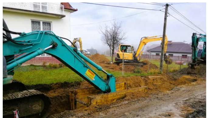
Kanalizacja w Mystkowie
