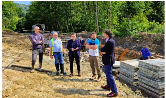
Stabilizacja osuwiska Wolniki
